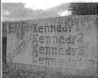
Façade Principale de l'Ecole
